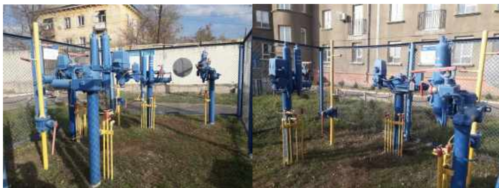
Рисунок 1 – Крановая площадка учебного полигона
